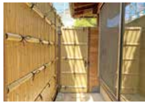
建仁寺垣の目隠しを新設
